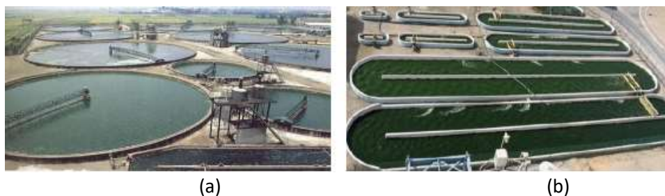
Figura 11 - Tanques abertos “Circular pond” (a) e “raceway pond” (b) Instalação real.
